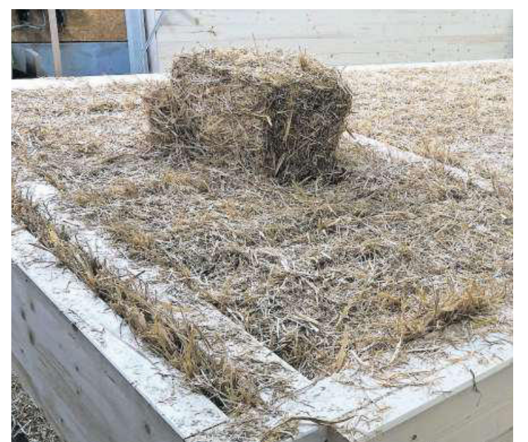
Für die Wandelemente werden in die Rahmen aus Brettschichtholz Kleinballen aus Stroh gepresst. Bild: PD
