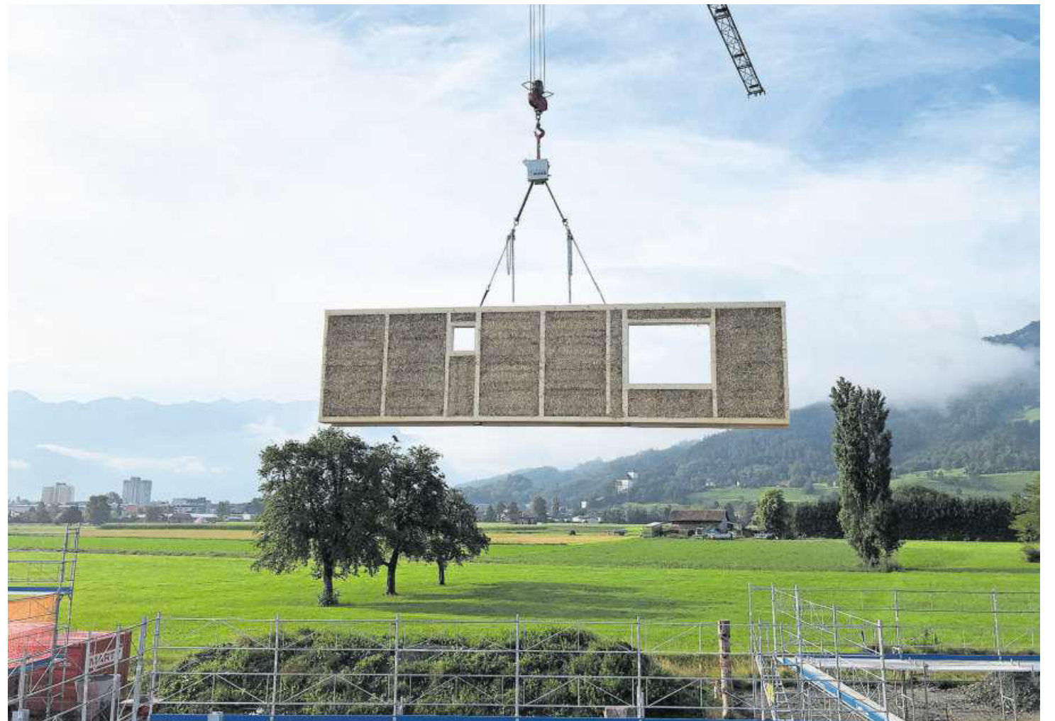
Die vorgefertigten Strohelemente werden mit dem Kran platziert.
